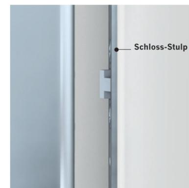
**03** Durch den metallischen **Schloss-Stulp** wird beim Schließen der Tür ...
